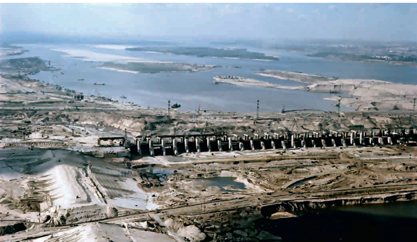
Панорама строительной площадки Цимлянской ГЭС. 1950–1951. Фото С.О. Фридлянда
