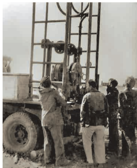
Бурение скважин для питьевой воды в п. Красный Яр Верхнекумского р-на [РГАЭ. Ф. 5675. Оп. 1. Д. 806. Л. 155–156]
