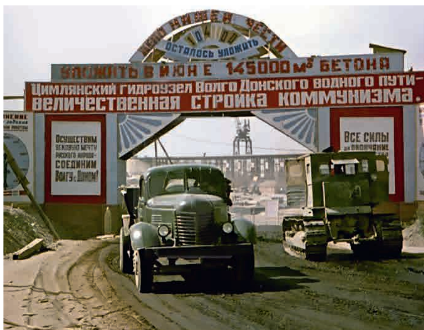
Въезд на территорию строительства Цимлянской ГЭС. Фото А. Гостева
