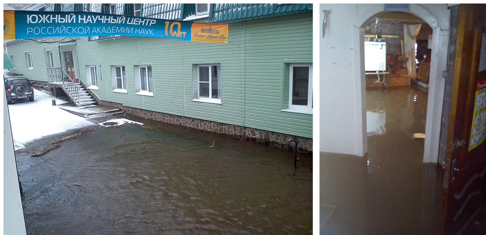
Рис. 5. Подтопленные здания в с. Кагальник, Азовский район
