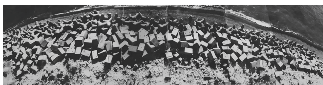
Рис. 2. Наброска из массивов и тетраподов перед корпусом 6 [4].
