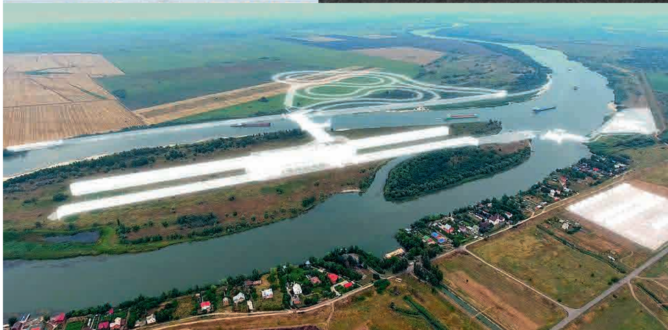
Строительство Багаевского гидроузла, 2018 г.
