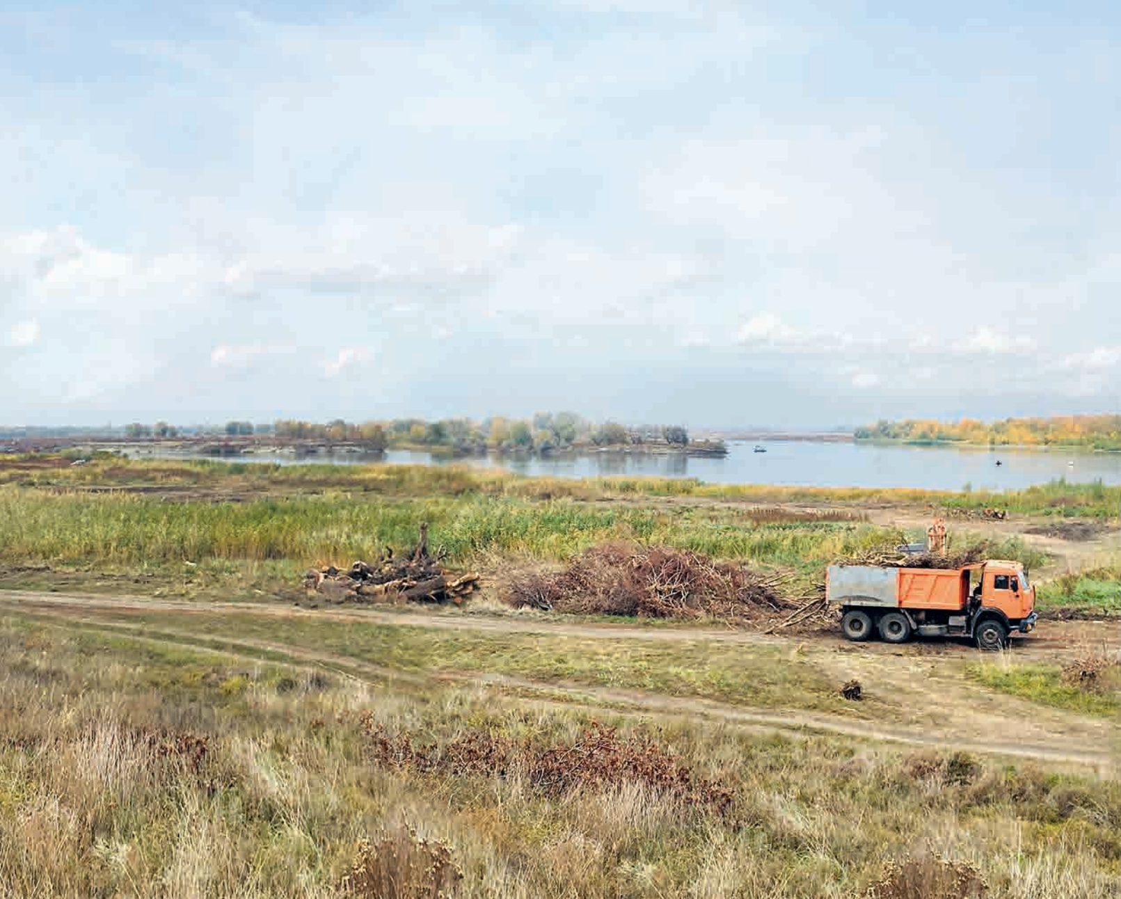
Вид на стройку Багаевского гидроузла со стороны х. Арпачина, 2018 г.
