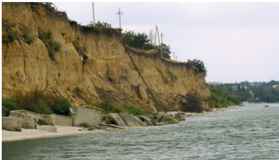
Рис. 1.5. Участок северного побережья Таганрогского залива (западнее г. Таганрог), подверженный разрушению (фото В.В. Польшина, 2013)
