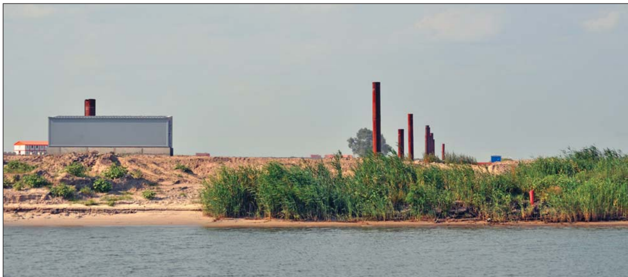
Строительство Багаевского гидроузла. 2022 г.
