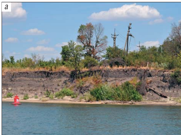
Последствия речной эрозии: поврежденная линия электропередач у станции Раздорской (а) и разрушающееся кладбище в станции Мариинской (б).
