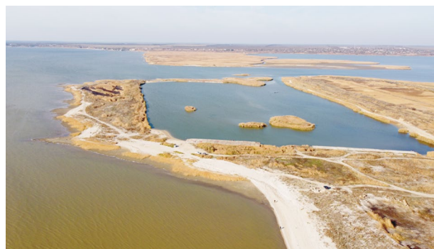
Вид на недостроенные в начале 1990-х гг. портовые сооружения в устьевой зоне Миусского лимана.
