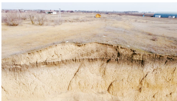
Фрагменты восточного бастиона Семеновского шанца – земляной крепости начала XVIII в.
